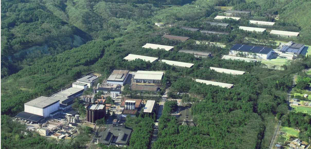
写真 3-2: 大規模な P2G システムを導入するサントリーの白州工場
