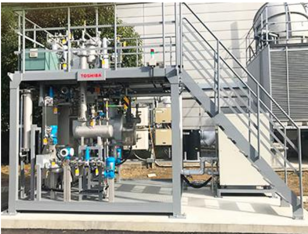
写真 2-3:アサヒグループ研究開発センターで実証中の CO 2 分離回収試験装置(左)、メタネーション装置(右)
