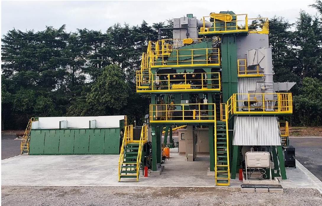
出典: 大林道路
