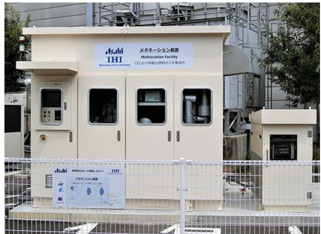
写真 2-3:アサヒグループ研究開発センターで実証中の CO 2 分離回収試験装置(左)、メタネーション装置(右)
