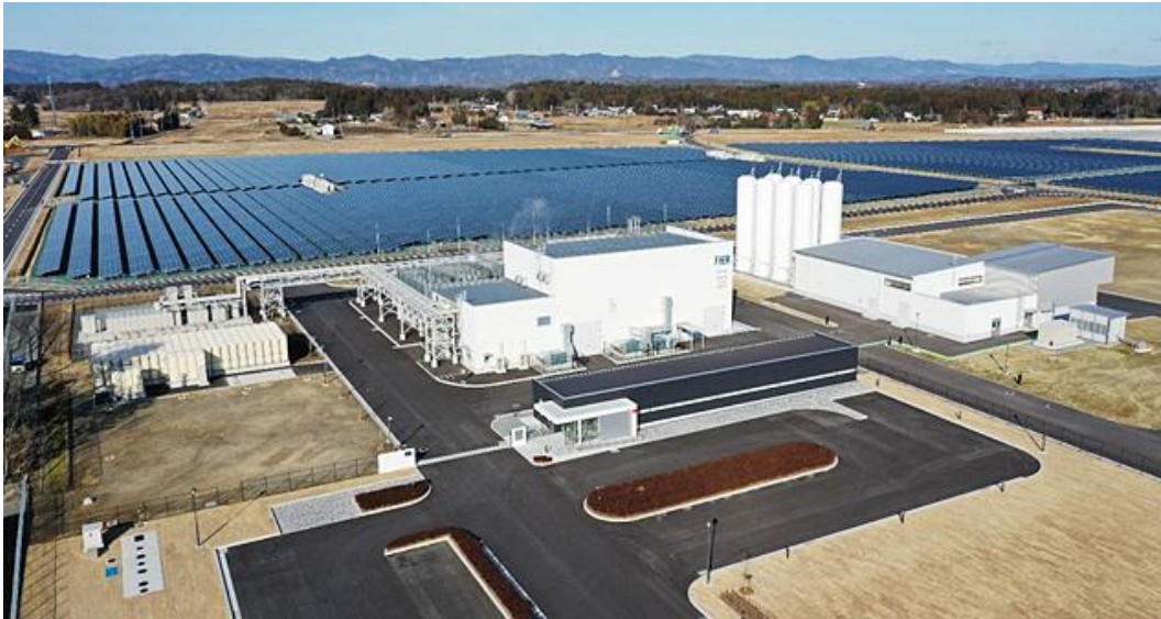
写真 3-3:「福島水素エネルギー研究フィールド(FH2R)」の全景
