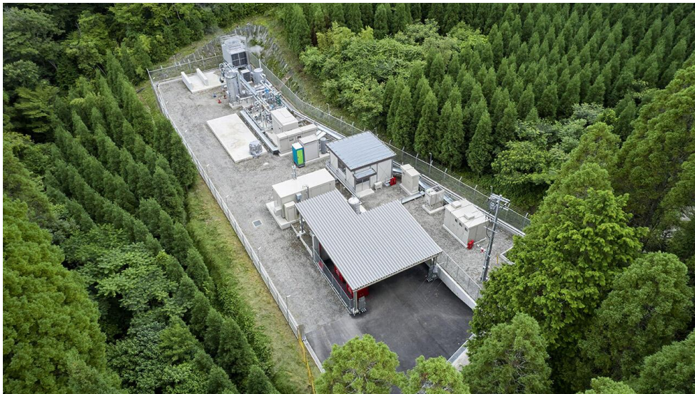
写真3-4:地熱発電の電力から水素を製造する実証プラント
