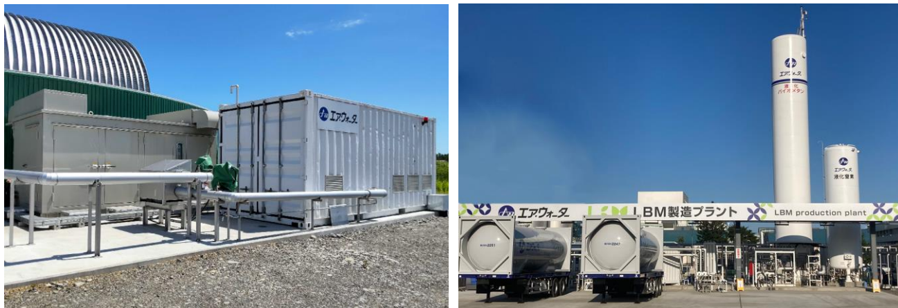
写真 2-4: バイオガス捕集システム(左)、液化バイオメタン製造プラント(右)
